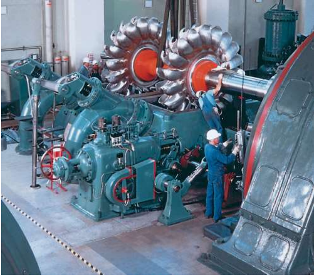
Figura 14 - Turbina Pelton Fonte: CERPCH (1998)
