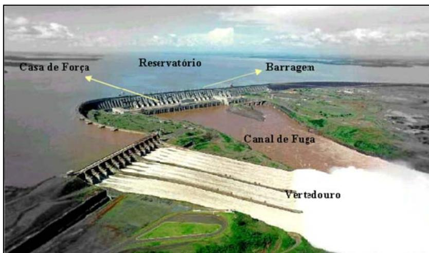
**Figura 9: Principais componentes de uma usina hidrelétrica.**
