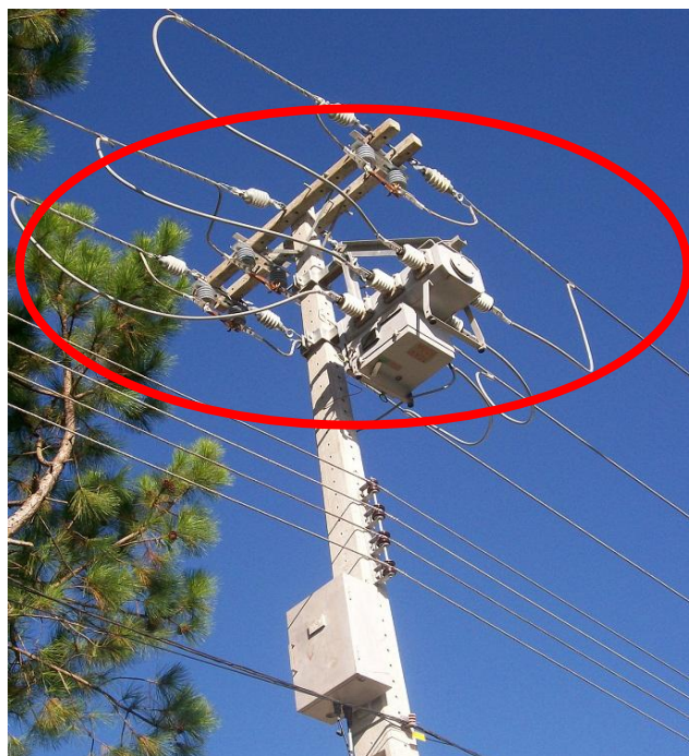
Figura 29: Secc instalado modelo JK-GAC SBS-15. Fonte: As autoras.
