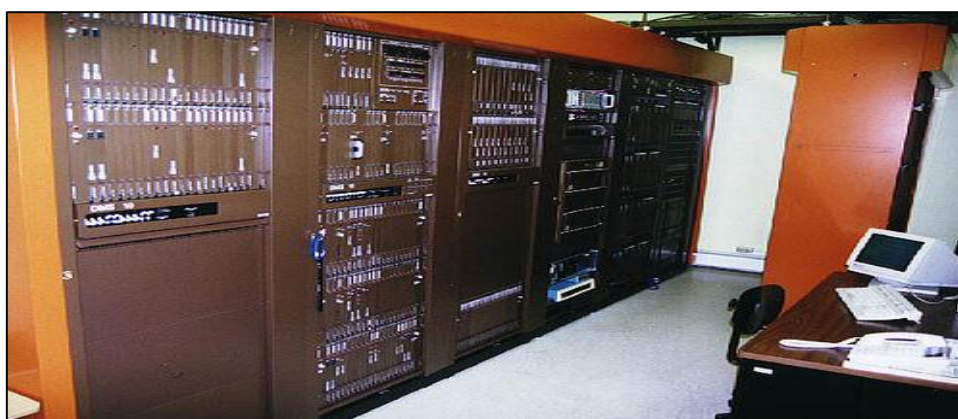
Figura 25: Bastidores de uma central TDM, a DMS-100. Fonte: Afiler (2015).
