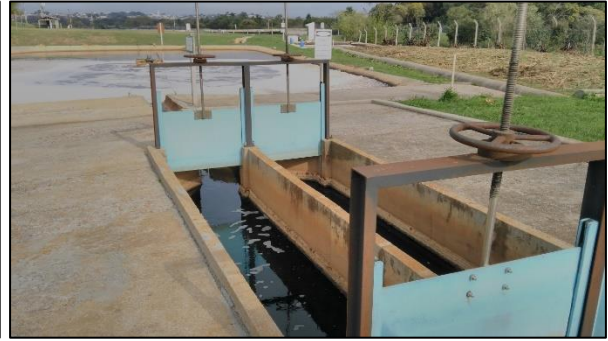
Figura 7 – Calha Parshall
