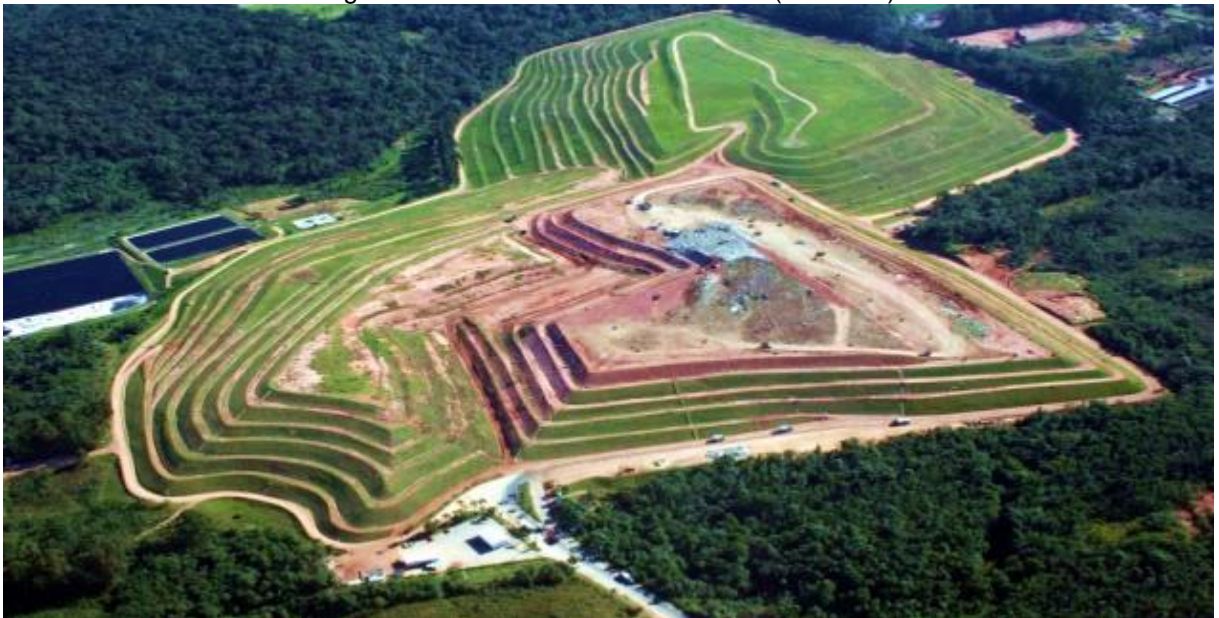
Figura 5 – Aterro sanitário de Curitiba (Caximba)
