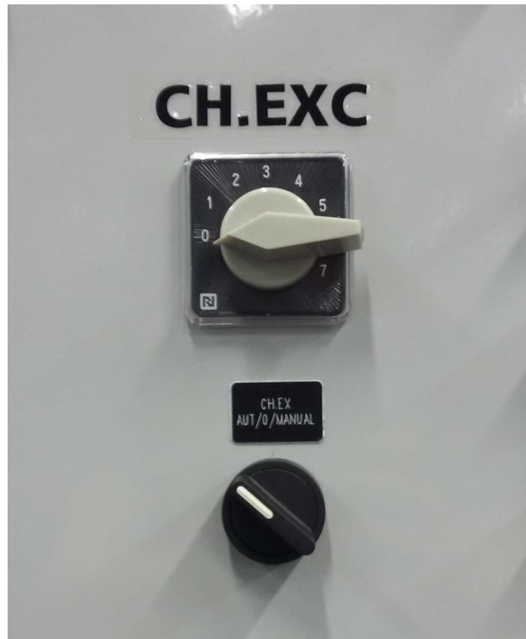
Figura 28: Chaves de excitação da corrente de campo. Fonte: Autoria própria.
