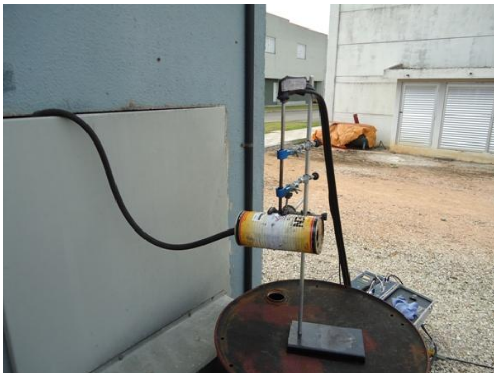
Figura 9 – Fotografia do sistema de exaustão adaptado
