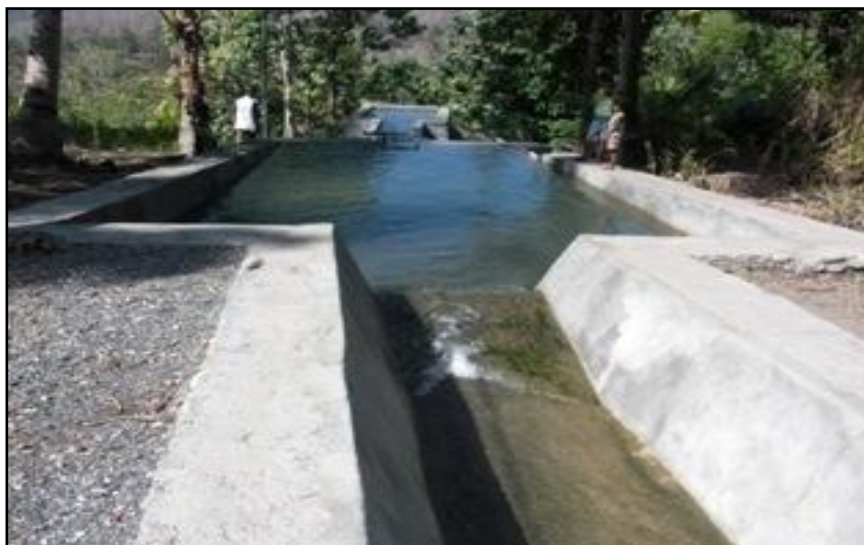
Figura 5– Foto: Canal de conduto de água para central hídrica em Loihuno
