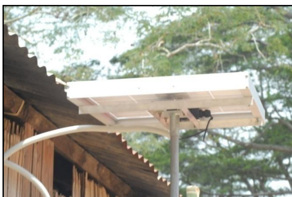
Figura 12– Foto: Instalação de módulo fotovoltaico na casa localizada em áreas isoladas
