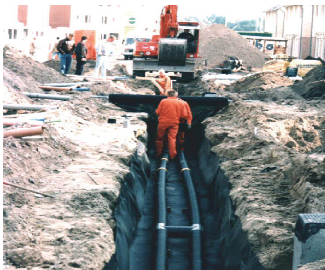
Figura 12 – Construção de trincheira de infiltração em Schellerhoek, Zwolle Fonte: Beenen e Boogaard (2007)
