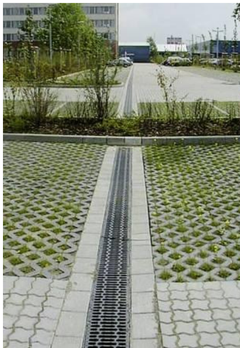
Figura 10 – Pavimento permeável Fonte: Santos (2011)
