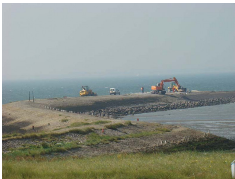
Figura 11 – Construção de diques na Holanda Fonte: Eerten (2011)
