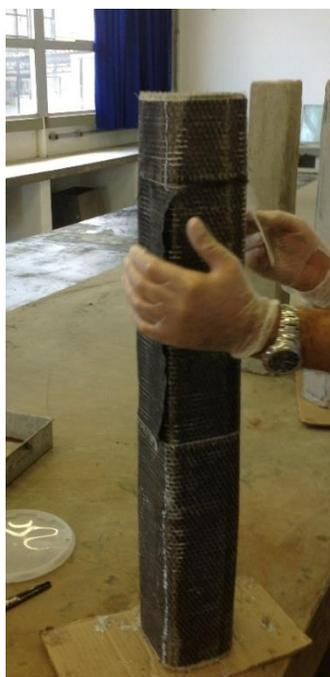
**Figura 12 - Aplicação da segunda camada de fibra de carbono**
