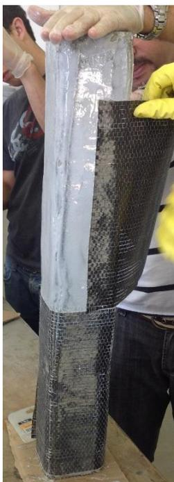
**Figura 11 - Aplicação da primeira camada de fibra de carbono**
