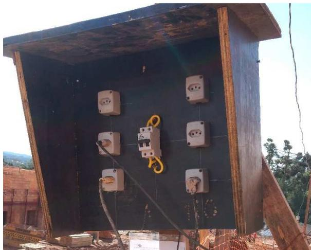
**Figura 13 – Instalação elétrica provisória.**
