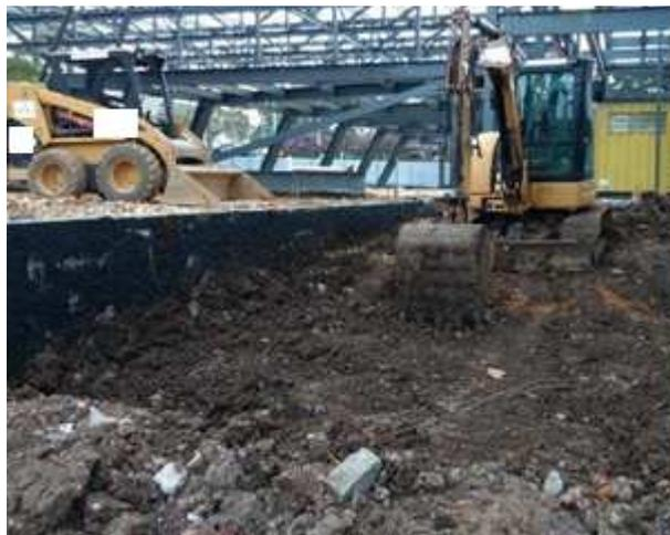
**Figura 27 – Máquinas em trabalho sem proteção em sua área.**
