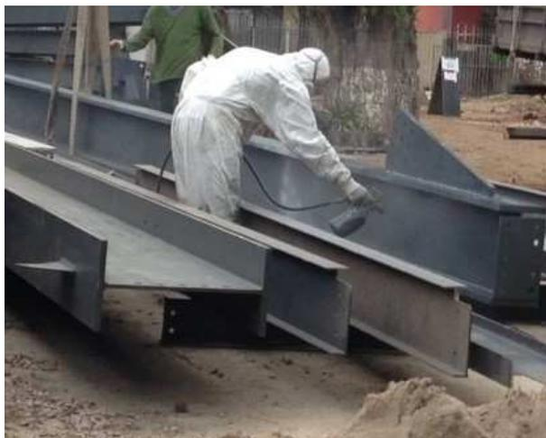
**Figura 28 – EPI para pintura de estrutura metálica.**
