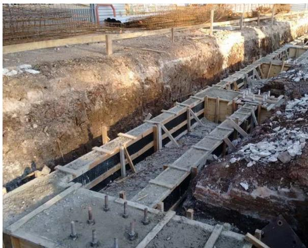
**Figura 22 – Formas para concretagem.**
