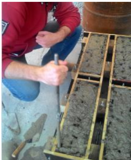
Figura 10. Adensamento do concreto.
