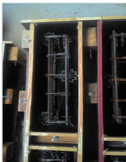
Figura 9. Forma e armadura antes da concretagem.
