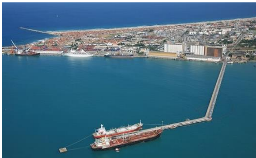
Figura 03 - Porto de Fortaleza, Brasil – Molhe de proteção
