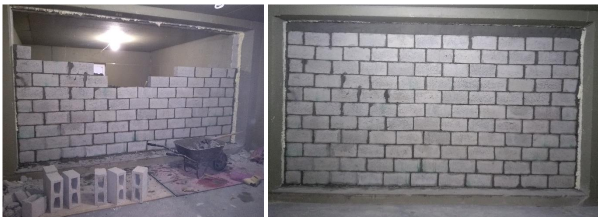
Figura 49 - Montagem da Parede com Bloco de Concreto - Agregados de RCD
