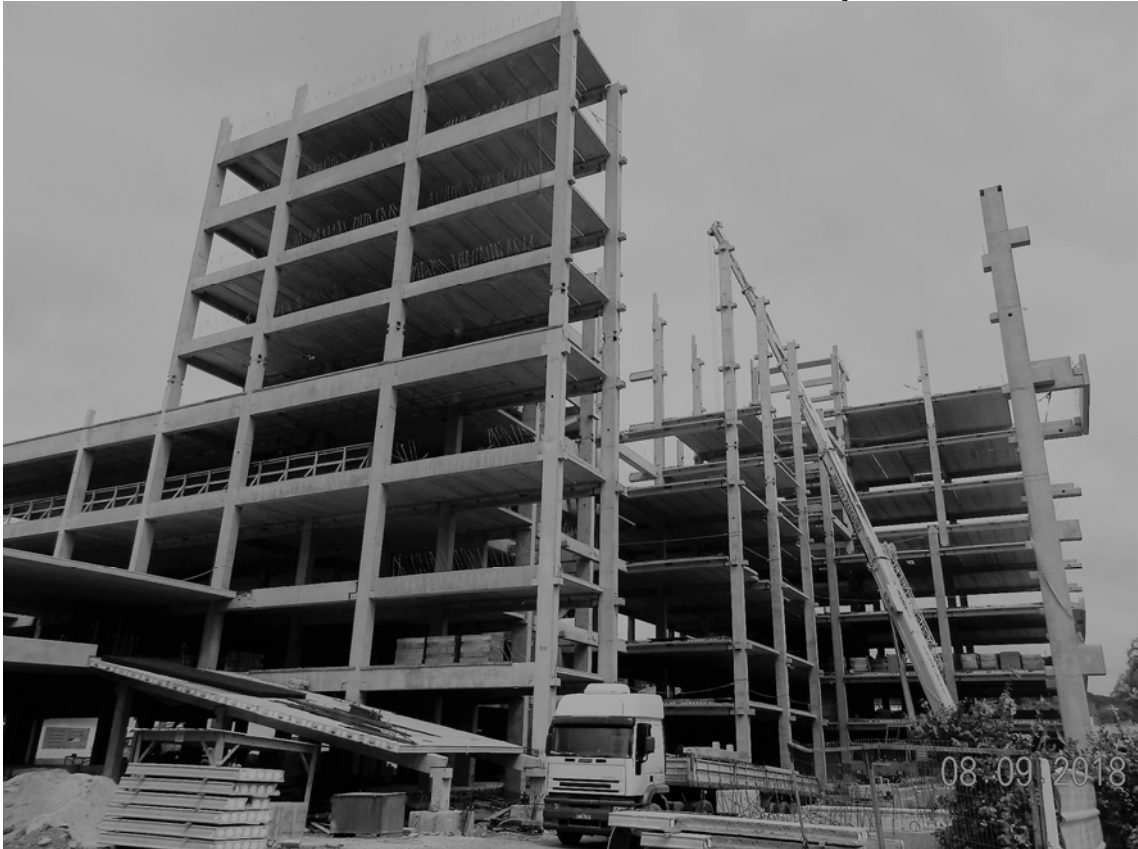
FOTOGRAFIA 6 FASE DE MONTAGEM - ESTRUTURA COM LIGAÇÕES SEMIRRÍGIDAS
