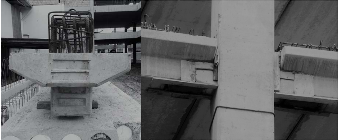
FOTOGRAFIA 4 LIGAÇÃO SEMIRRÍGIDA
