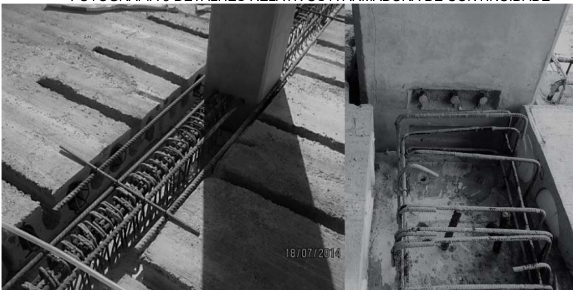
FOTOGRAFIA 5 DETALHES RELATIVOS À ARMADURA DE CONTINUIDADE
