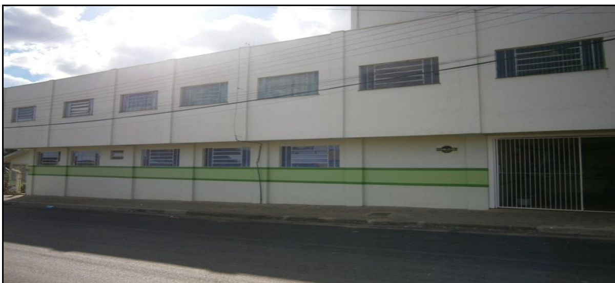
Figura 5 – Fachada da escola 2
