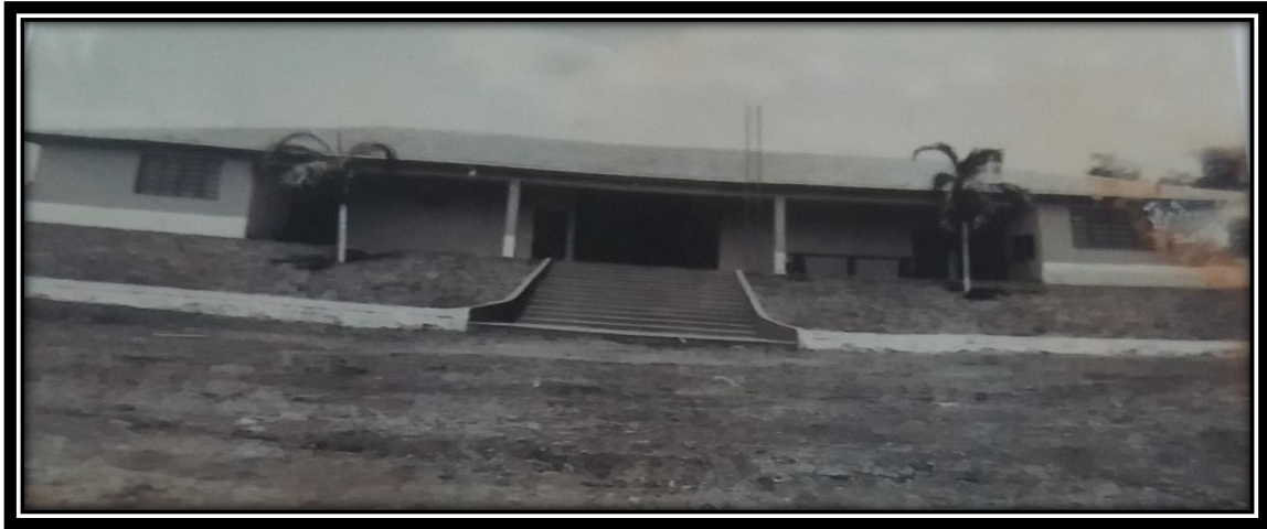
Figura 7: Novo prédio da Casa Escolar, constuído em 1975.
