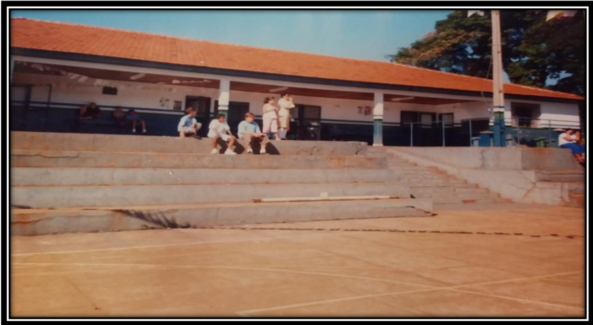
Figura 8: Fachada da Escola no ano de 2003.
