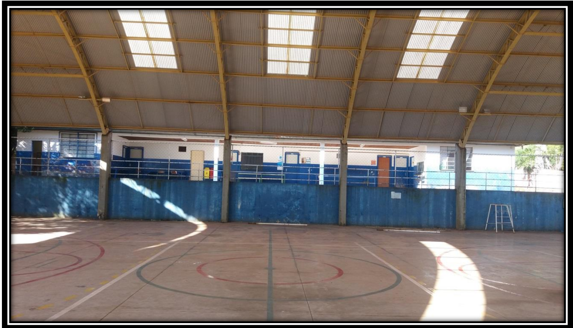
Figura 9: Fachada da Escola nos dias atuais vista de dentro da quadra- ano de 2017.
