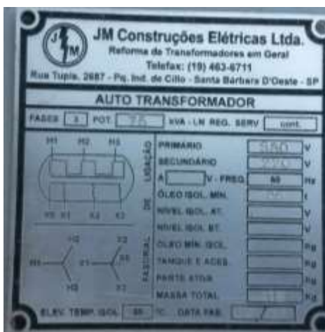
Figura 3 - Dados de placa do transformador conectado em Y-Y aterrado.
