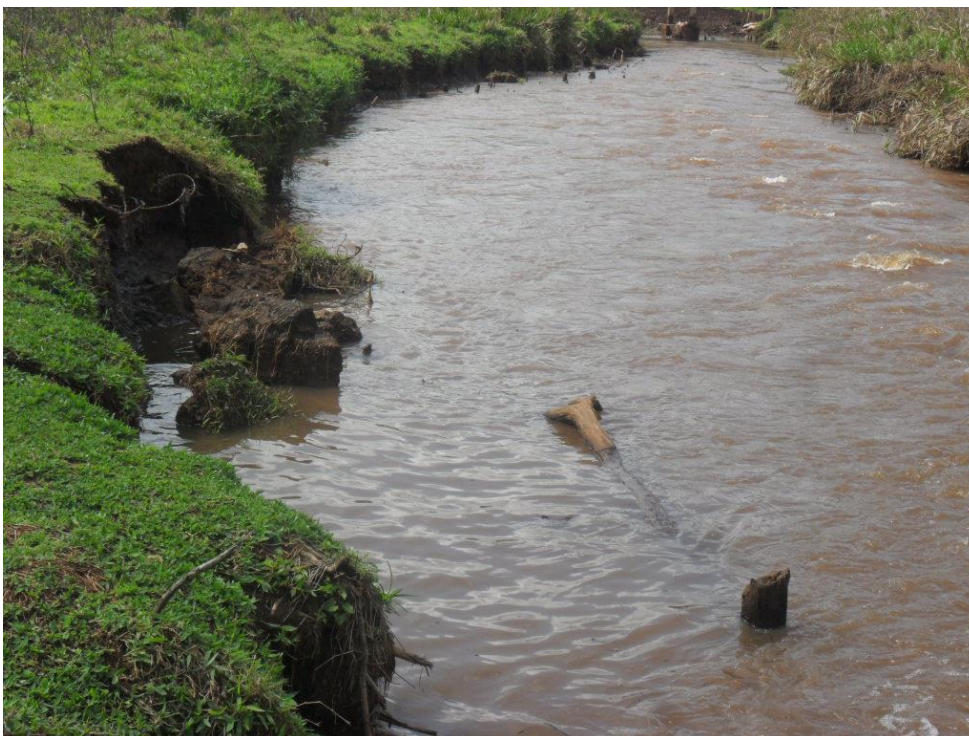
Figura 10 - Taludes após a queda devido o excesso de umidade no solo na entrada reservatório, Parque Municipal de Campo Mourão, PR.
