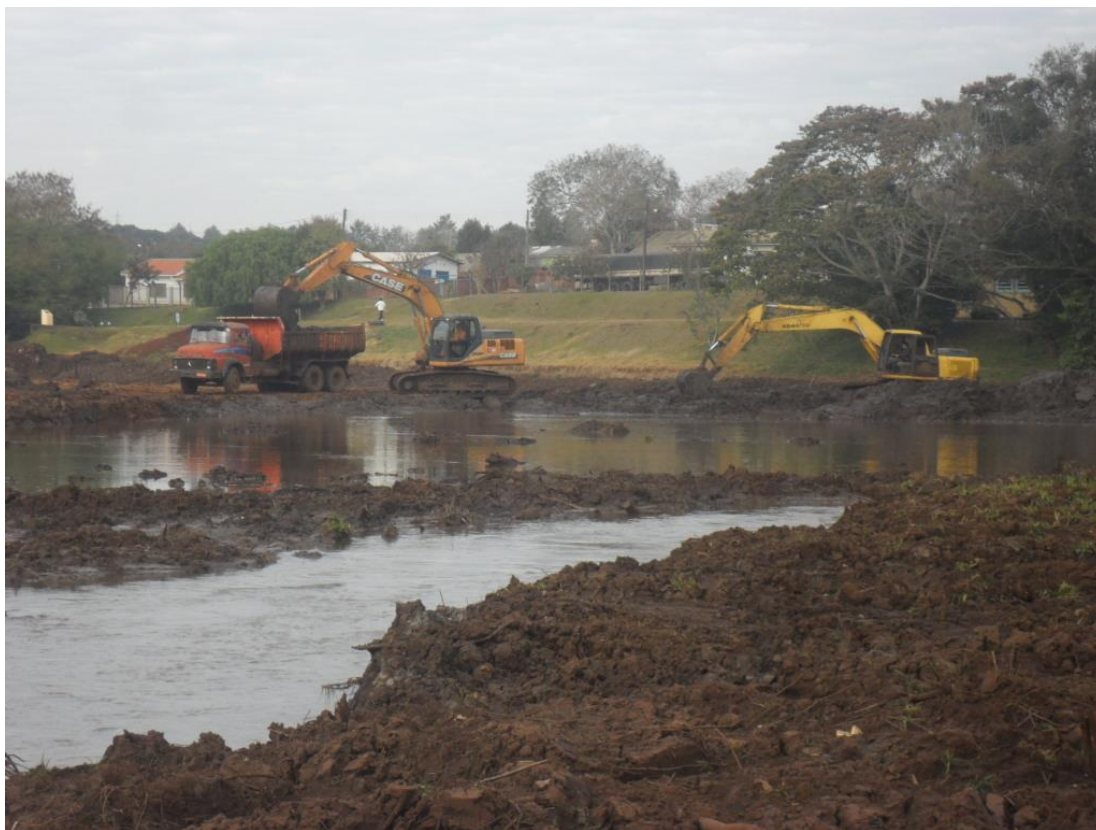
Figura 14 - Dragagem no reservatório com sedimentos expostos, passíveis de arraste pela chuva, Campo Mourão, PR.
