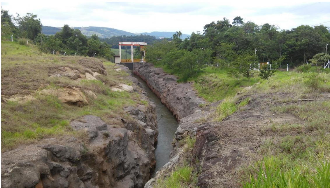
Foto 11: Vista da casa de força da PCH Salto Natal e do canal artificial (3km) construído para desvio do rio Mourão, localizada em Campo Mourão – PR. Fonte: Acervo particular.
