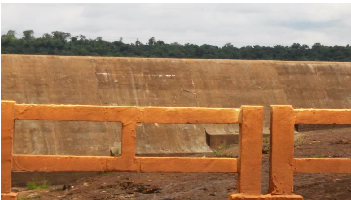
Foto 10: Barragem da Usina Hidrelétrica Mourão I, localizada em Campo Mourão – PR. Fonte: Acervo particular.
