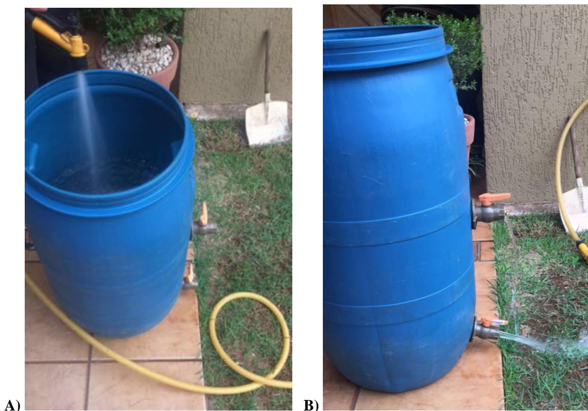
Figura 4 - Teste de vazamento dos registros instalados no biodigestor doméstico, utilizando água. A) Enchimento do biodigestor com água. B) Abertura dos registros para detecção de vazamentos.
