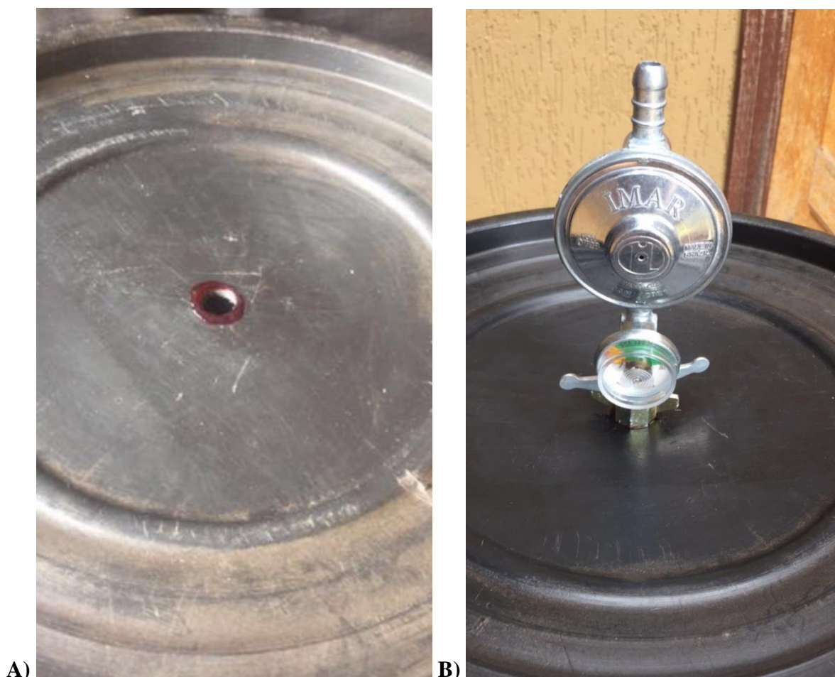
Figura 5 - Perfuração da tampa e instalação do registro de gás, A) e B), respectivamente.
