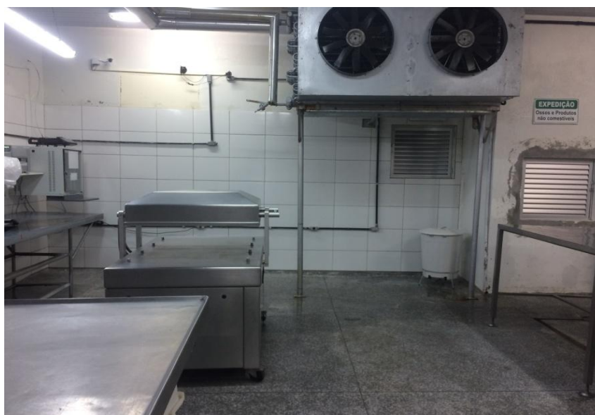
Figura 75 - Após a reforma
