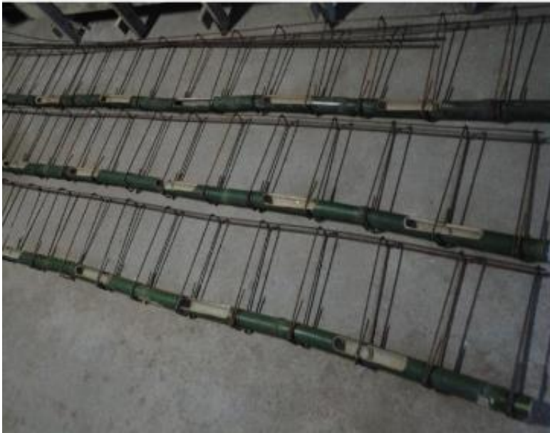
Figura 10 – Vigas de bambu com os estribos de aço.
