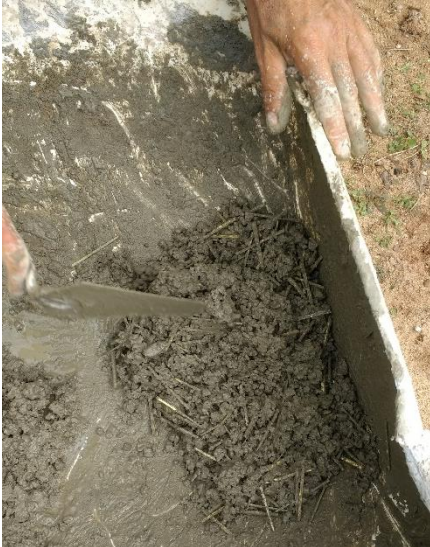
Figura 33 – Fibras de bambu misturadas manualmente com o concreto.
