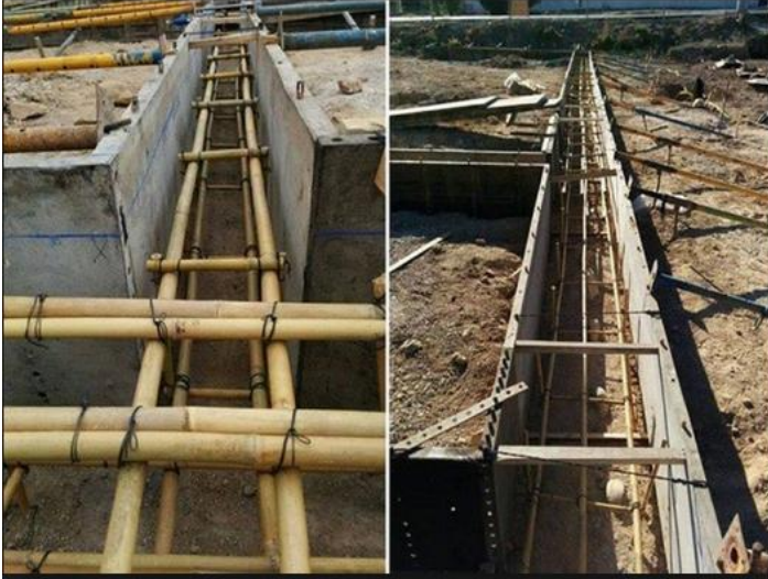
Figura 12 – Viga de concreto armado com bambu roliço.
