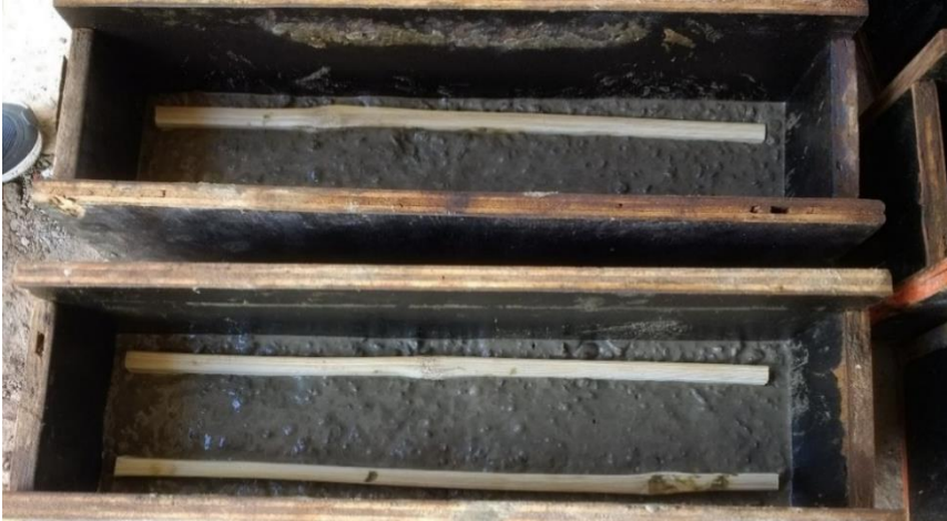
Figura 28 – Disposição das armaduras de bambu na forma.
