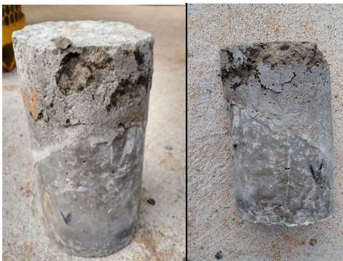
Figura 15 - Rompimento no concreto novo (Compound)
