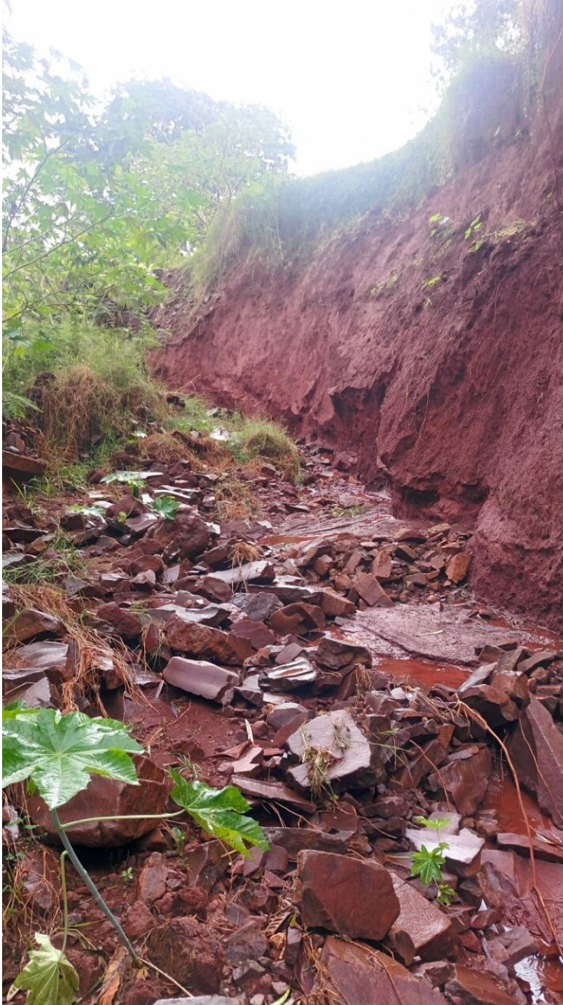
Figura 16 – Rochas na área inferior a tubulação.
