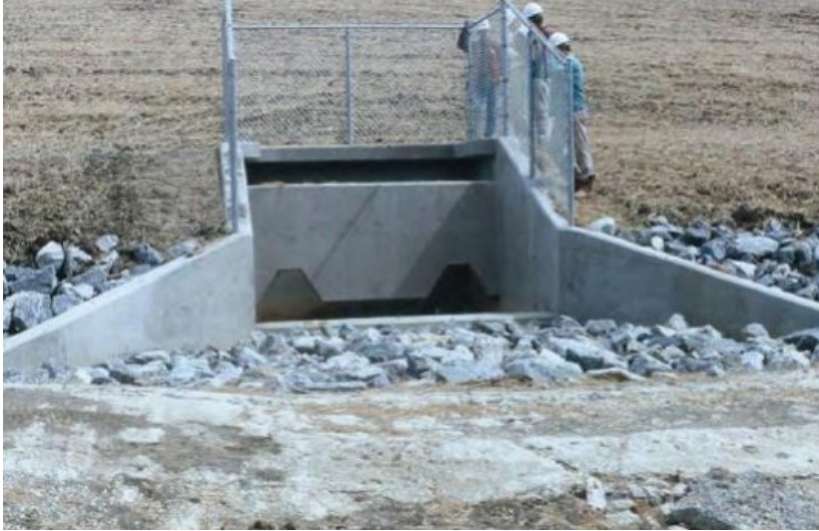
Figura 11 – Dissipador por bloco de impacto.
