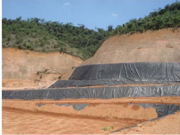
Figura 5 – Impermeabilização da fundação de um aterro sanitário.
