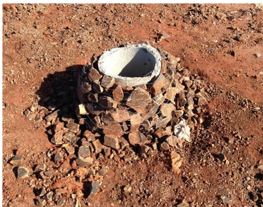
Figura 17 – Sistema de drenagem de gases no Aterro Sanitário do município 1. Fonte: Acervo pessoal (2017).
