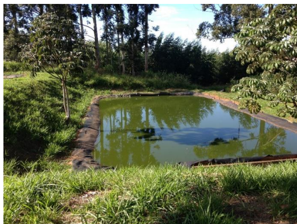
Figura 15 – Lagoa de tratamento de chorume no Aterro Sanitário do município 1. Fonte: Acervo pessoal (2017).
