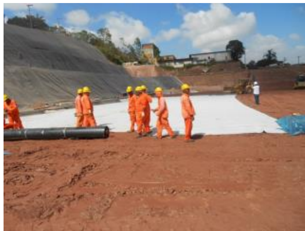
Figura 6 – Aplicação do Geocomposto Bentonítico em um aterro sanitário. Fonte: MEUCCI (2004).
