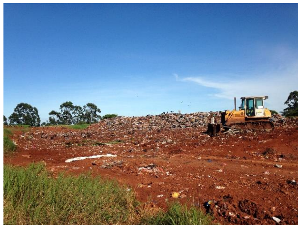
Figura 9 – Aterro Sanitário do município 1. Fonte: Acervo pessoal (2017).
