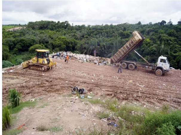
Figura 2 – Exemplo de aterro controlado. Fonte: http://www.dinamicambiental.com.br (2014).
