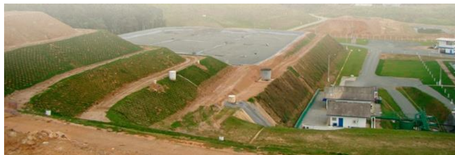
Figura 3 – Exemplo de Aterro Sanitário. Fonte: www.teraambiental.com.br (2014).
