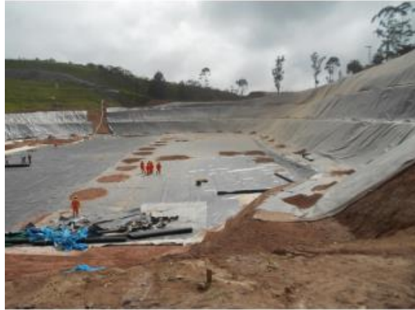
Figura 8 – Aterro Sanitário impermeabilizado com Geomembrana PEAD. Fonte: MEUCCI (2004).
