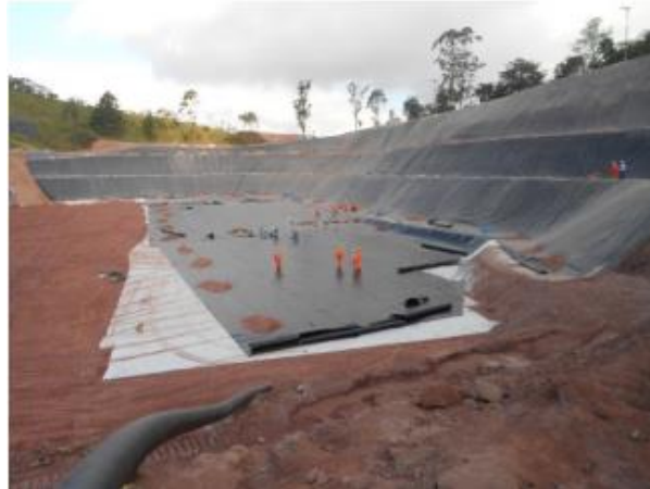
Figura 7 – Aplicação da Geomembrana PEAD sobre o Geocomposto Bentonítico. Fonte: MEUCCI (2004).
