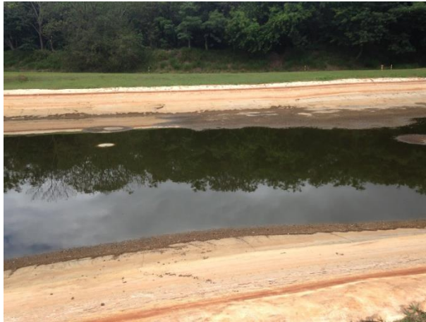
Figura 16 – Lagoa de tratamento de chorume no Aterro Sanitário do município 2. Fonte: Acervo pessoal (2017).
