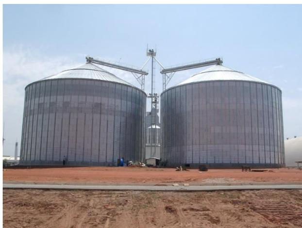
Figura 6 - Silos Metálicos de fundo plano
