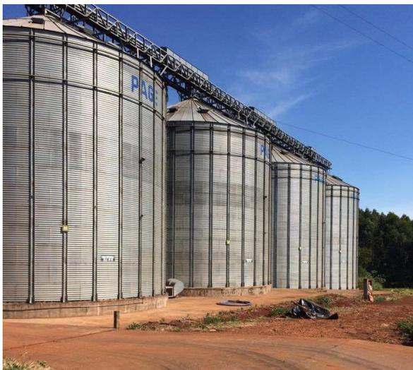
Fotografia 1 - Silos Metálicos de Fundo Plano
