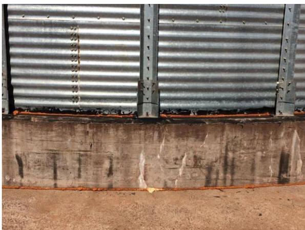
Fotografia 2 - Base de concreto tipo feixe circular
