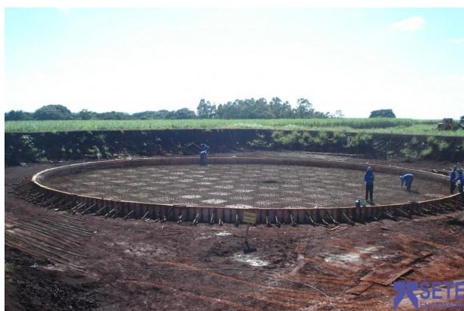
Figura 10 – Base de concreto tipo laje
