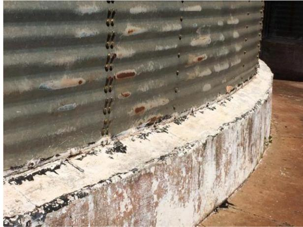
Fotografia 5 - Corrosão da estrutura metálica próximo à base de concreto
