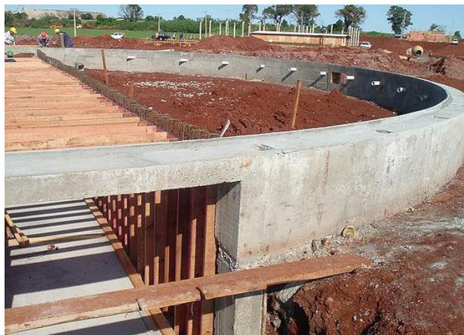
Figura 9 – Base de Concreto de feixe circular
