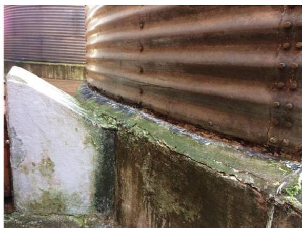
Fotografia 4 - Musgos na base de concreto de silos
