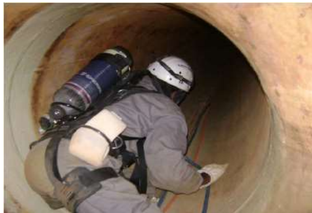
Figura 2-20 – Local confinado (Reis, Freitas 2013)
