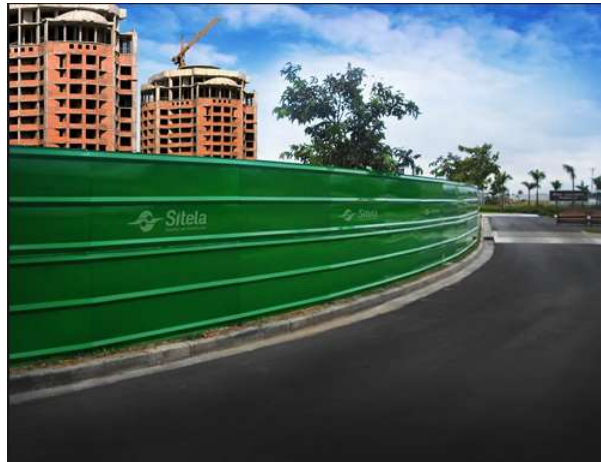
Figura 2-26 – Tapume em volta da obra (Sitela [no date])
