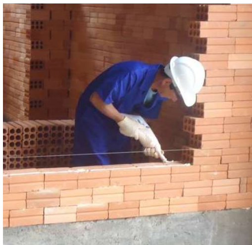
Figura 2-18 – Execução alvenaria (Habitissimo [no date])
