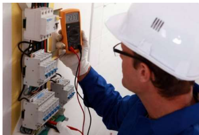
Figura 2-21 – Manutenção da instalação elétrica (Engenharia [no date])
