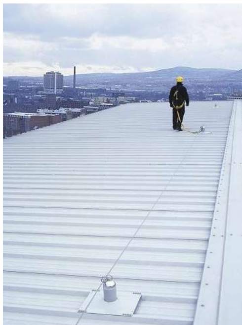
Figura 2-19 – Trabalho em cobertura (Brasil [no date])
