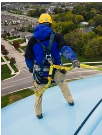
Figura 4-5 – Trabalhador com cinto tipo pára-quedista (Tuiuti 2015)
