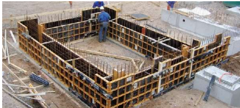
Figura 2-12 – Forma de madeira (Yago Duarte da Silva 2015)
