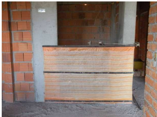
Figura 4-2 – Proteção do vão do elevador (Crusius 2011)
