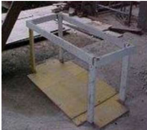
Figura 4-1 – Abertura de piso protegida (Medeiros [no date])
