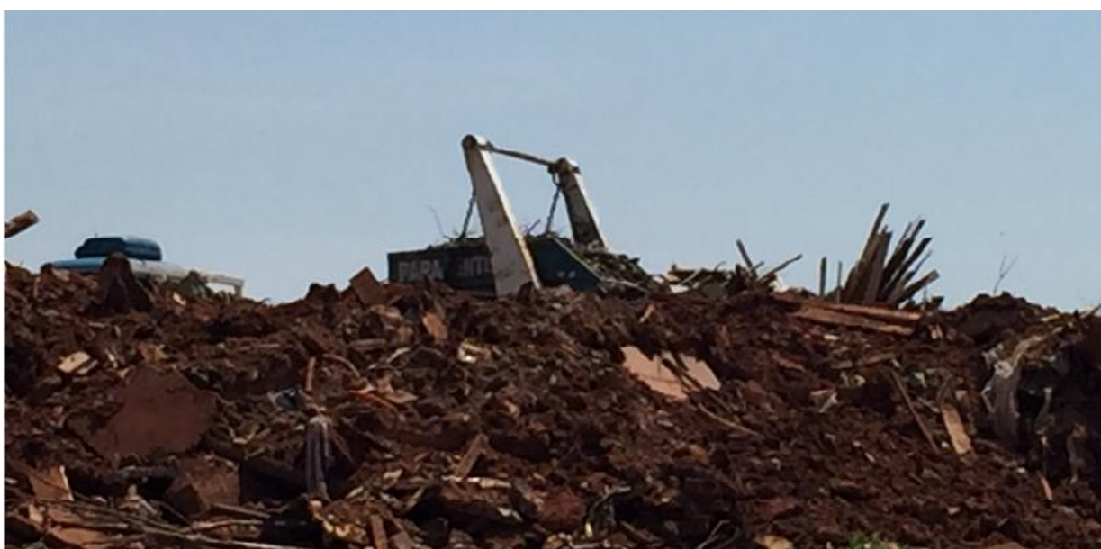
Figura 2 - Caçamba fazendo disposição dos resíduos no terreno cedido à ASTENCIA pela Companhia Melhoramentos Norte do Paraná, a fim de controlar o risco de erosão.
