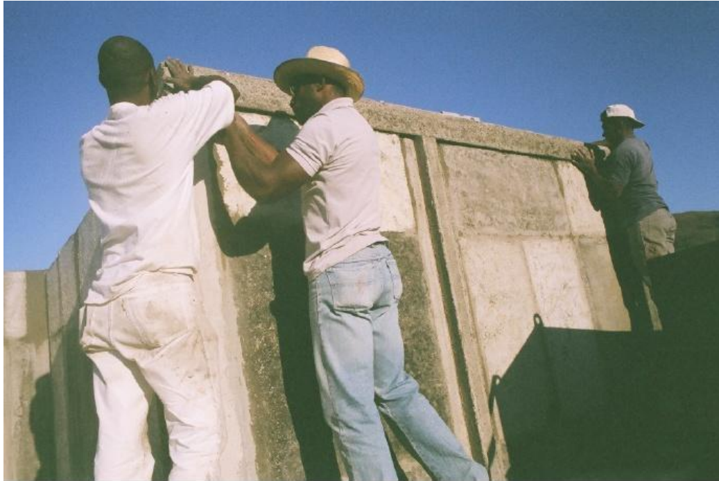
Figura 45 - Colocação da cinta de amarração Fonte: Marques (2011)
