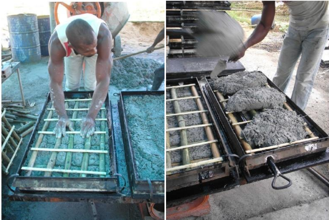
Figura 44 - Estrutura e armação das placas com bambu Fonte: Marques (2011)
