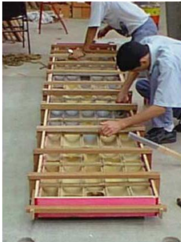
Figura 28 - Aplicação de Sikadur na forma permanente Fonte: Ghavami (2003)
