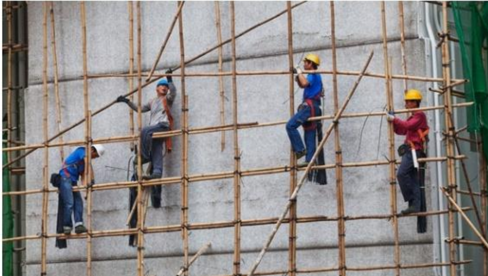
Figura 31 - Andaime de bambu de camada simples Fonte: Engenharia e Construção (2012)
