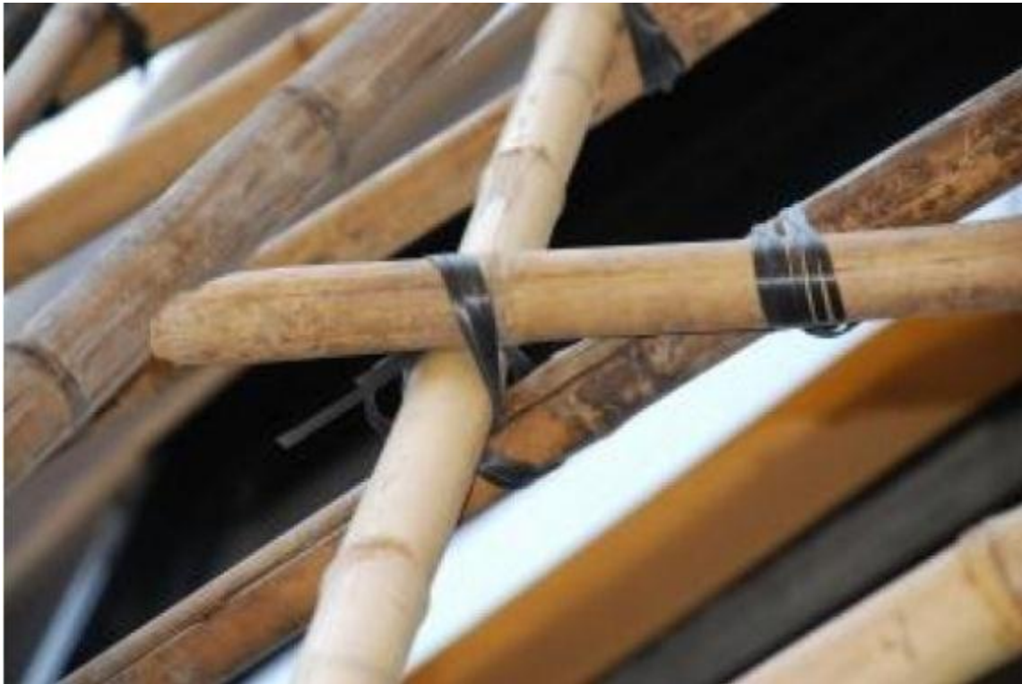
Figura 33 - Amarração das varas com tira de Nylon preta Fonte: Engenharia e Construção (2012)
