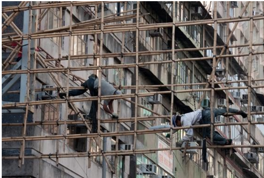
Figura 32 - Andaime de bambu de camada dupla Fonte: Engenharia e Construção (2012)
