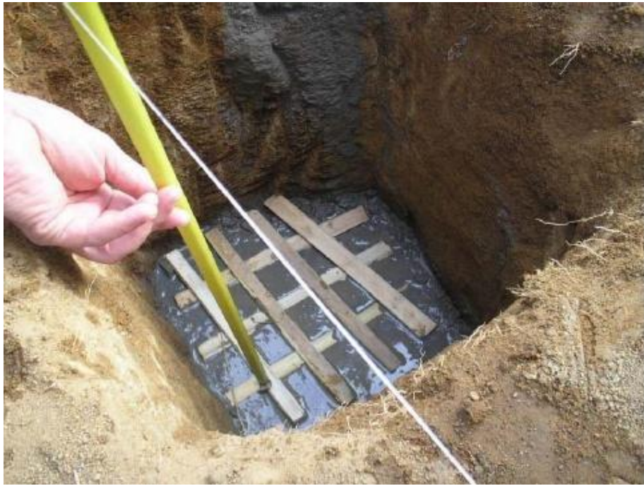
Figura 43 - Ilustração da armação de bambu em substituição ao aço Fonte: Marques (2011)
