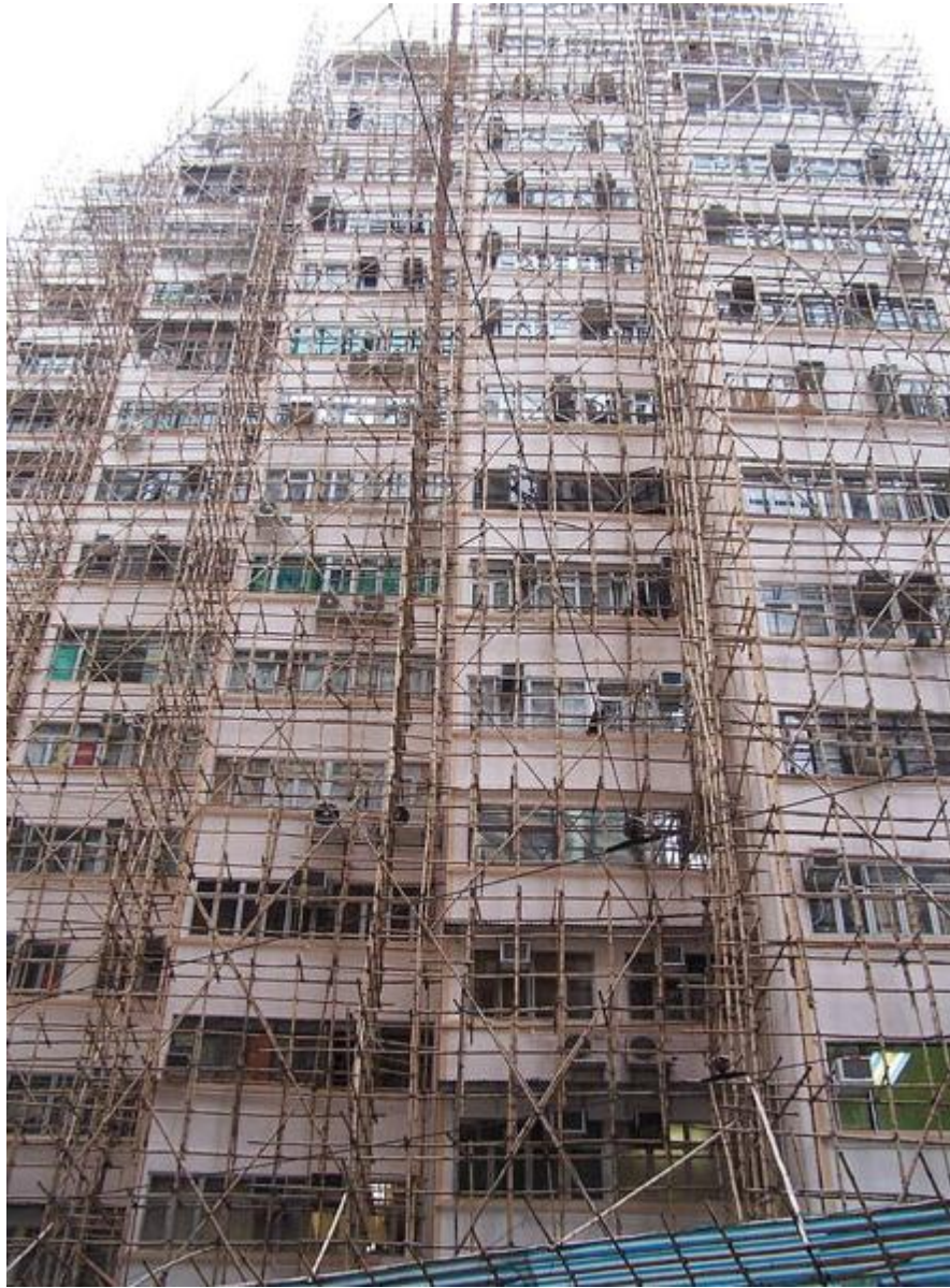
Figura 30 - Andaime de bambu em Hong-Kong Fonte: Maia (2009)
