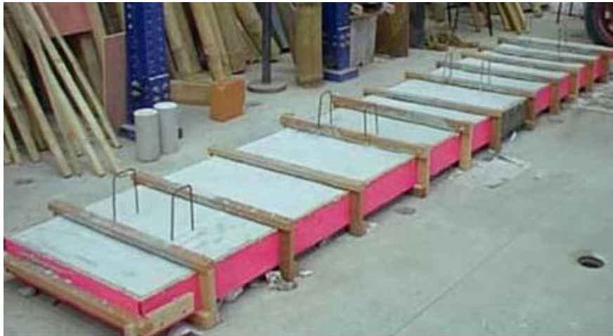
Figura 27 - Forma permanente preenchida com concreto Fonte: Ghavami (2003)
