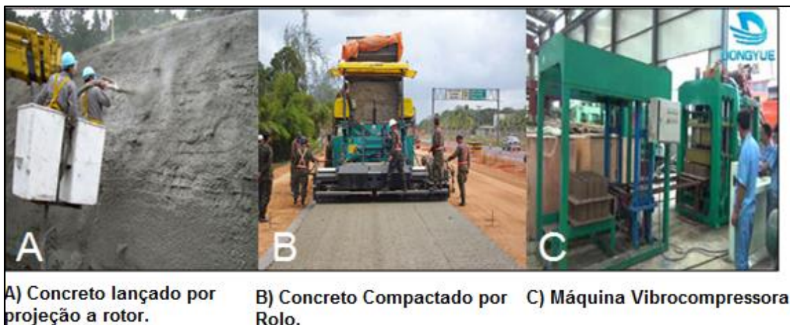
Figura 3 - Equipamentos empregados para concreto seco
