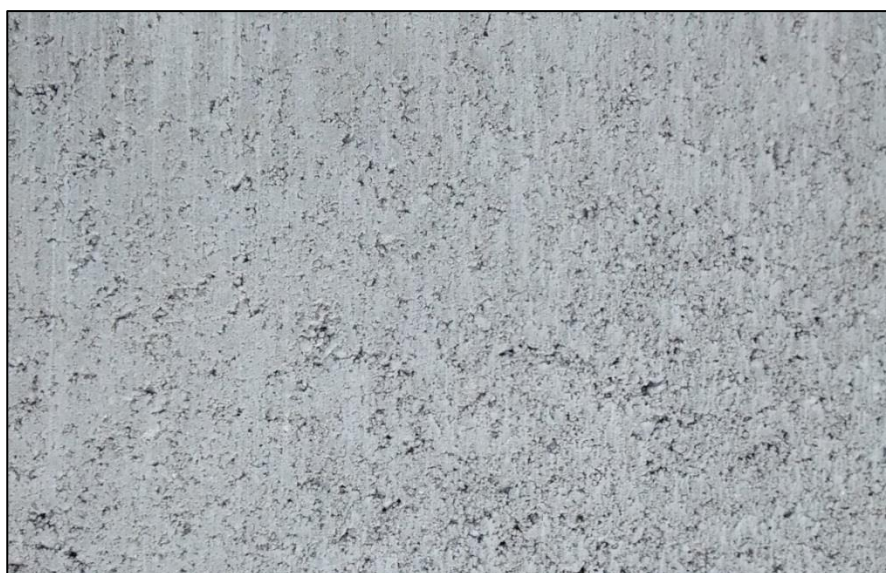
Figura 27 - Textura superficial bloco vedação empresa B Fonte: Autoria própria.
