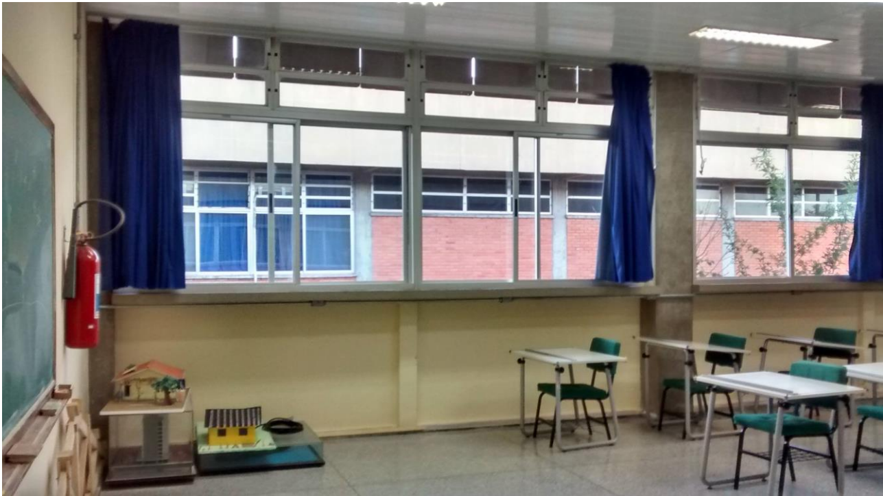
Fotografia 2: Aberturas laterais, proteção horizontal interna e vertical externa.
