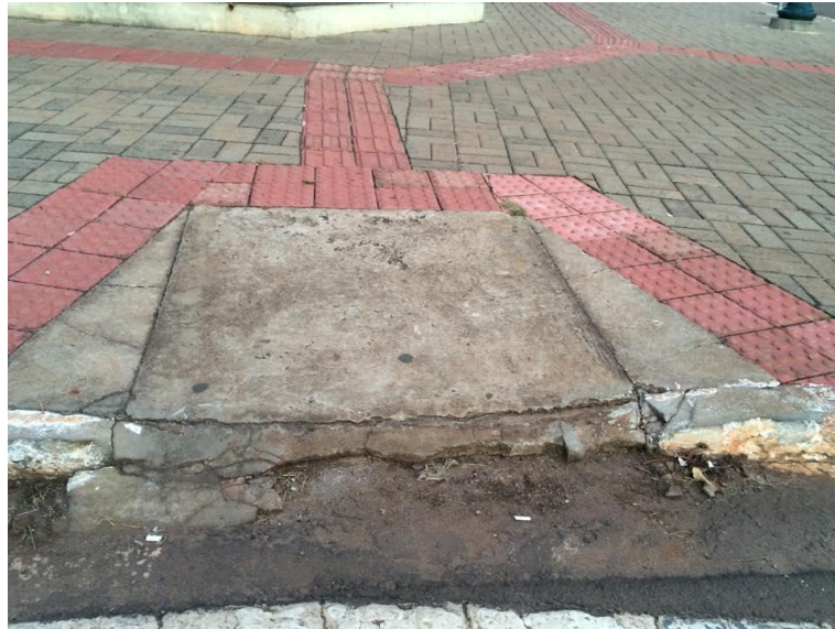
Figura 51 – Rebaixamento de guia com desnível Fonte: foto tirada pelo autor
