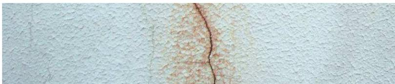
**Fotografia 7 – Manchas de infiltração devido à falta de impermeabilização do muro de contenção vizinha.**
