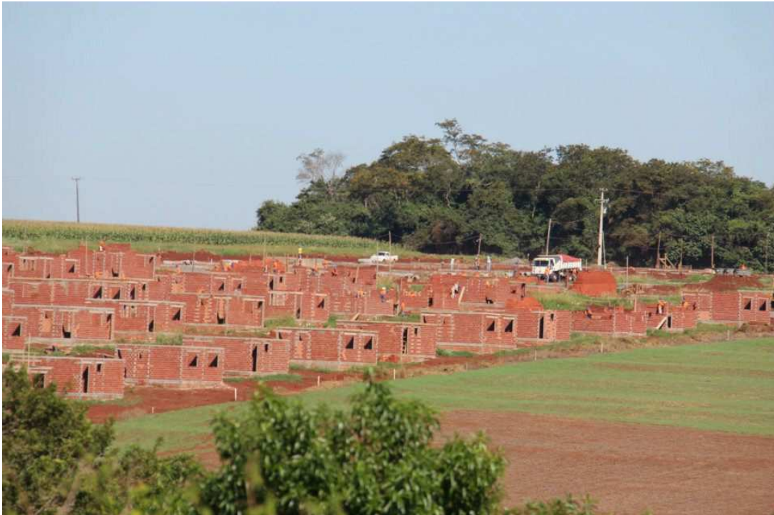
Figura 2 - Residencial Milton de Paula Walter no município de Campo Mourão - PR.
