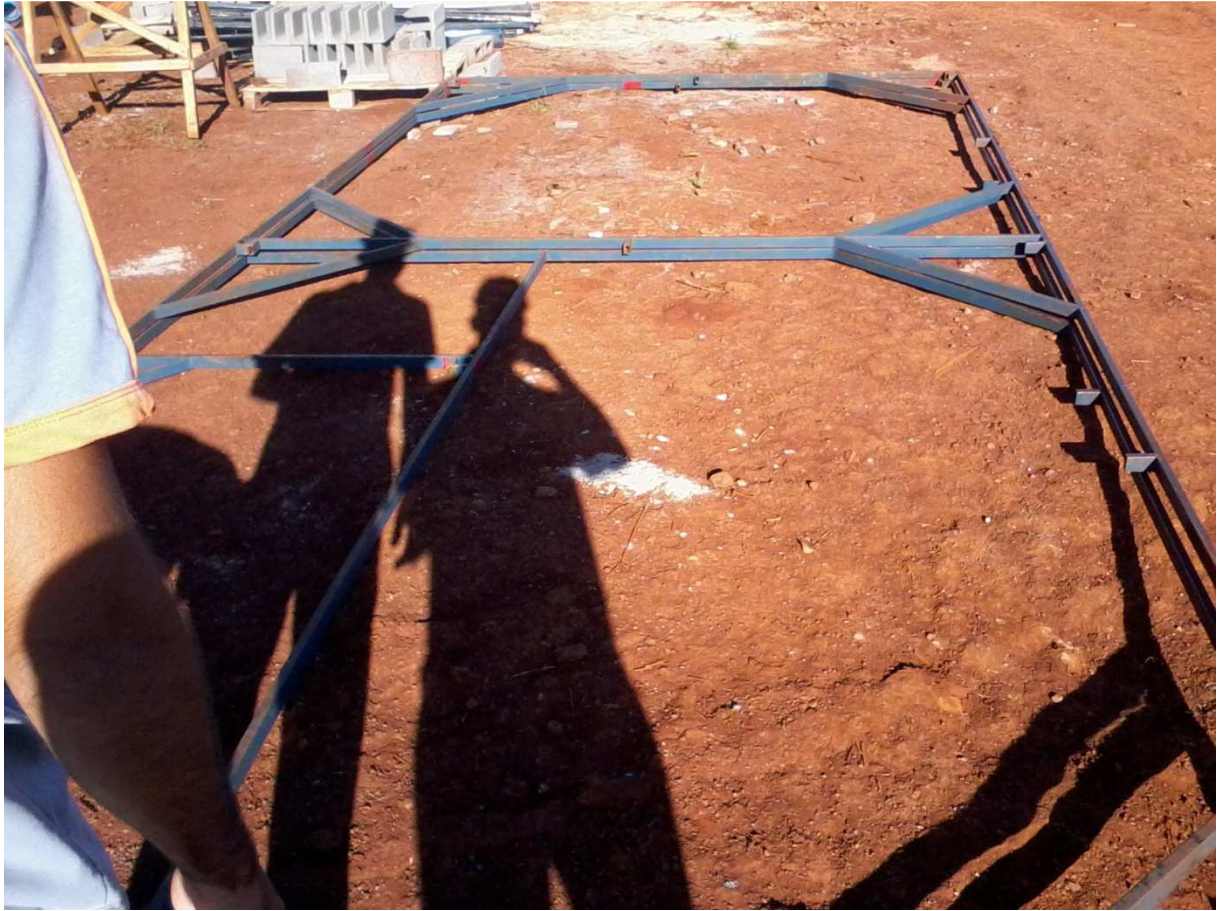
Figura 7- Gabarito Metálico usado para marcação do local de perfuração das estacas.
