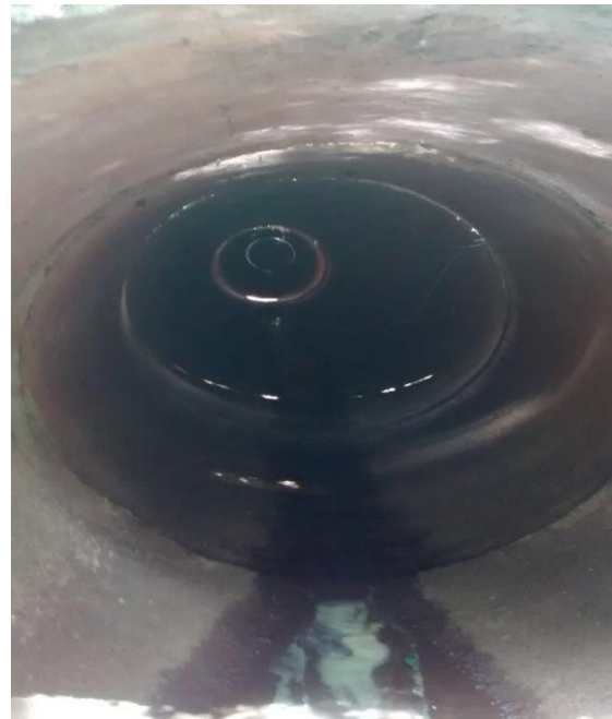
Figura 40 - Vista interna da tubulação.
