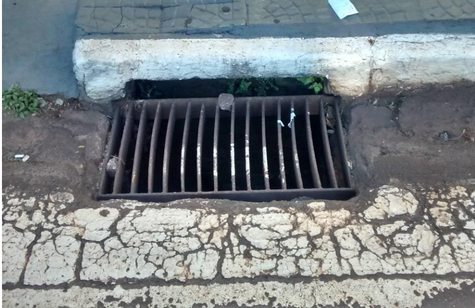
Figura 11 - Boca de lobo em Campo Mourão, Paraná Fonte: Autoria própria (2016).
