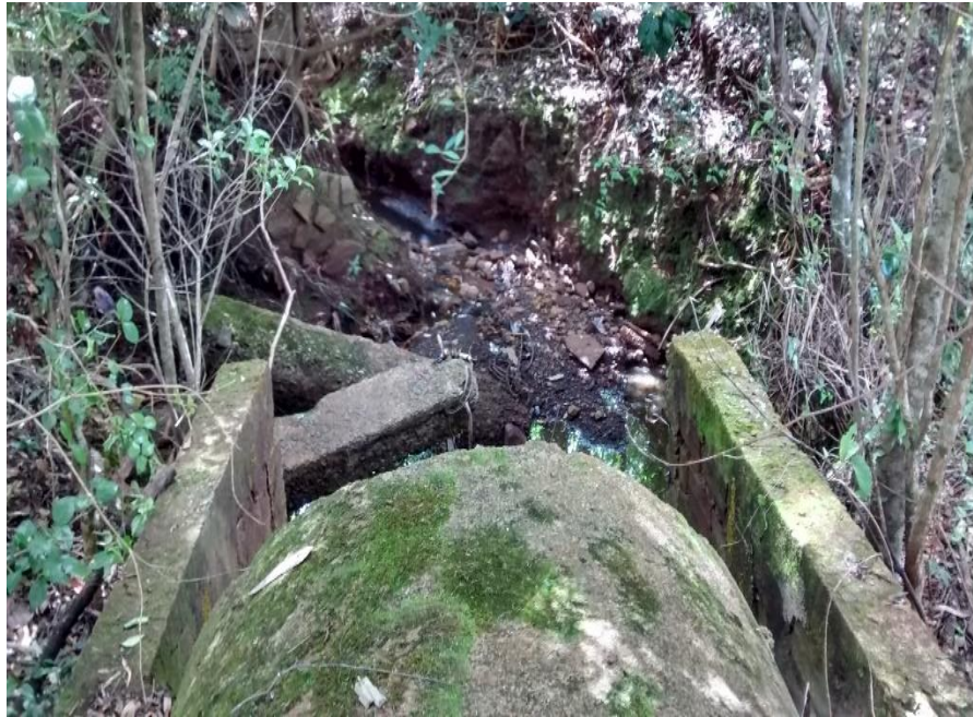
Figura 41 - Vista da saída do emissário 8
