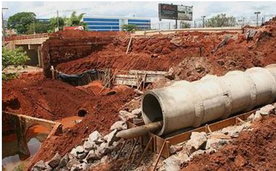
Figura 12 - Construção de uma tubulação de galeria de águas pluviais Fonte: Capitalnews (2010).
