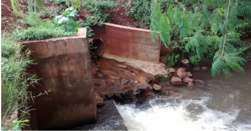
Figura 32 - Ponto de lançamento do emissário 2 no rio km 119
