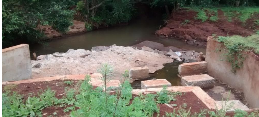
Figura 38 - Vista da saída do ponto de lançamento
