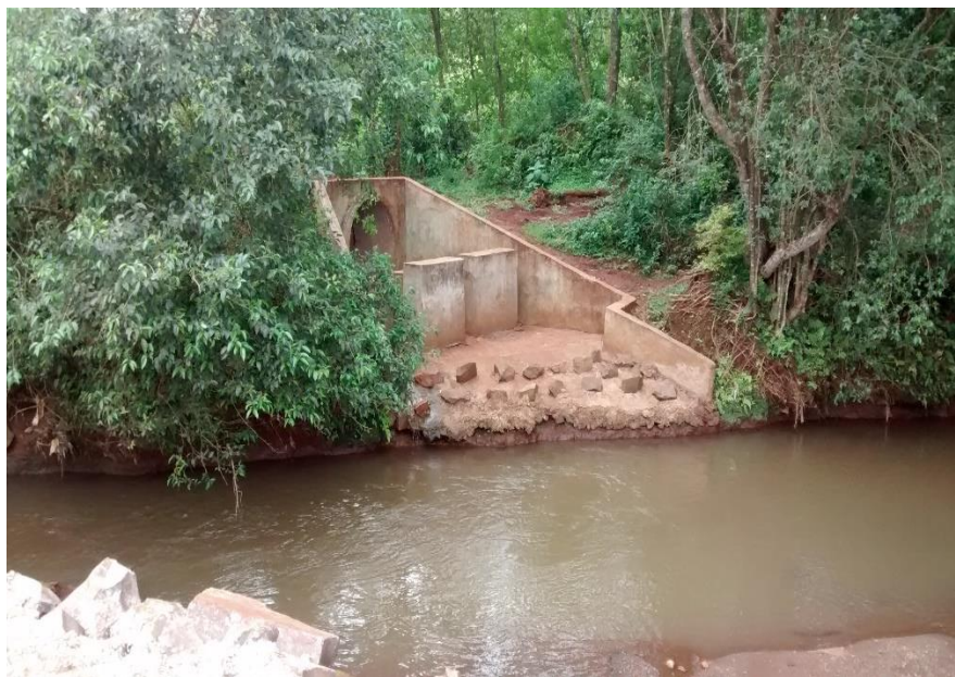
Figura 35 - Completa estrutura de dissipador de energia do emissário 5 Fonte: Autoria própria (2016)
