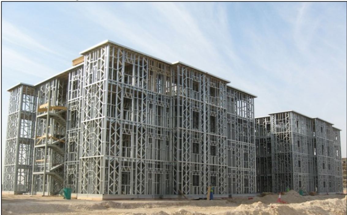
Figura 10 – Edifício em sistema construtivo steel frame
