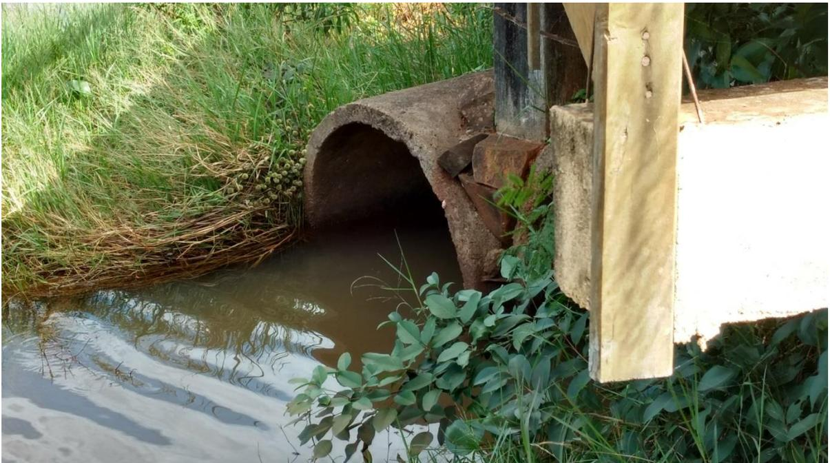
Figura 16. Emissário 2 parcialmente submerso e servindo de base para a estrutura da plataforma
