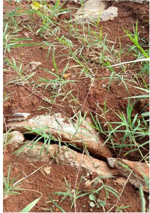
Figura 14. Rachaduras na tubulação
