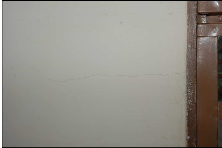
Figura 10 – Tensões na extremidade da janela.
