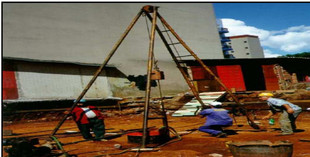
**Figura 5 - Equipamento completo com moto-bomba**
