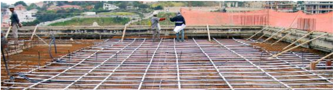
Figura 6: Exemplo de estrutura protendida Fonte: RUDLOFF (2015).
