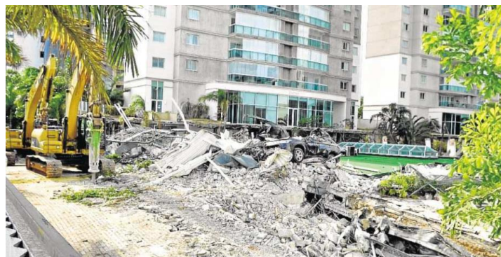
Figura 4: Ruínas do desabamento Fonte: SÁ (2017).
