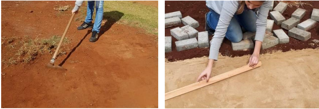
Figura 5.12 – Preparação do terreno
