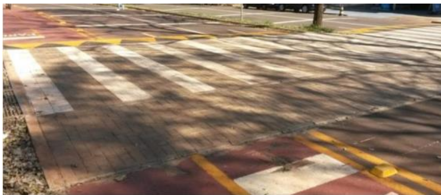
Figura 3.3 - Faixa de pedestre elevada
