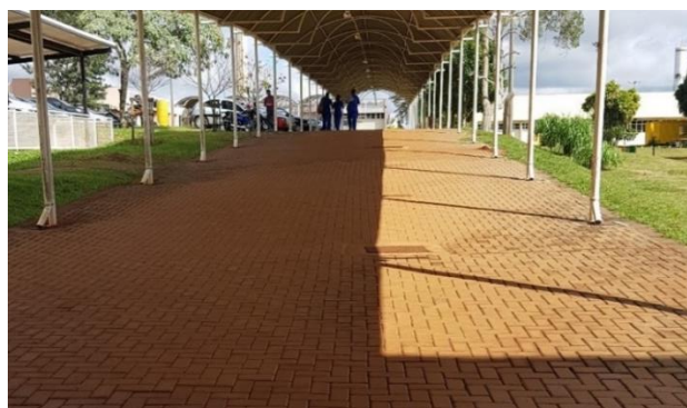
Figura 3.2 – Passarela Universidade Tecnológica Federal do Paraná – Campus Apucarana
