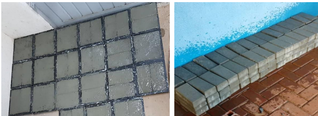
Figura 5.11 – Confeção dos blocos para as calçadas
