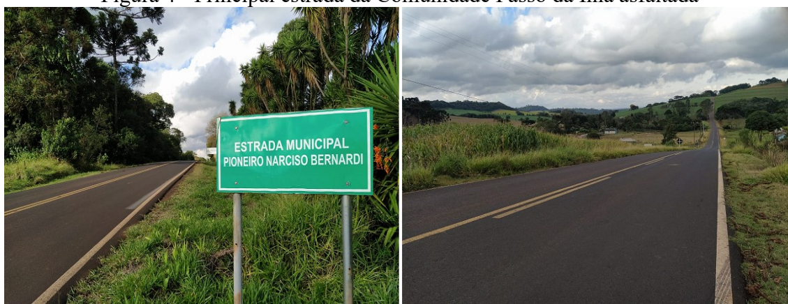
Figura 4 - Principal estrada da Comunidade Passo da Ilha asfaltada
