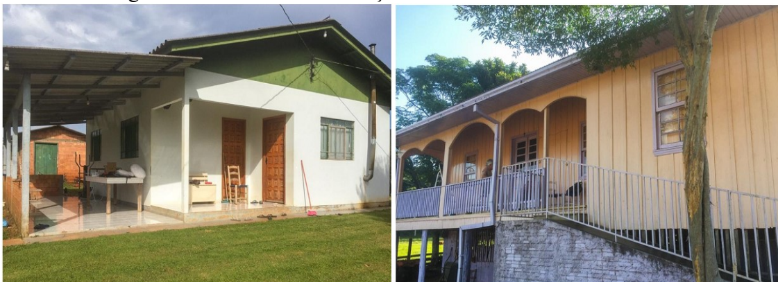
Figura 7 - Estado de conservação das residências do AF8 e AF7
