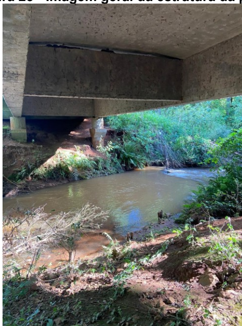
Figura 23 - Imagem geral da estrutura da ponte
