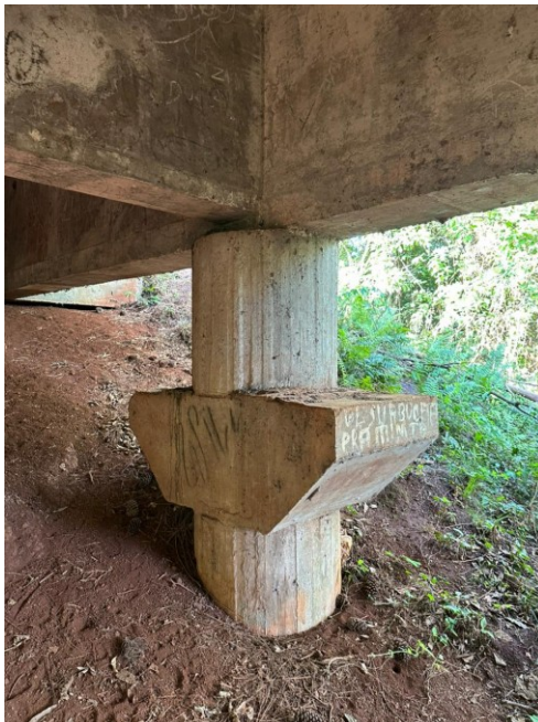
Figura 21 - Pilar em bom estado de conservação
