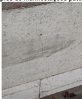
Fissura em viga
