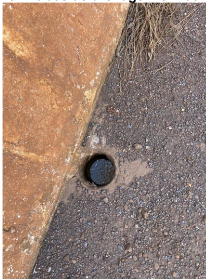
Figura 20 - Tubos de drenagem em bom estado
