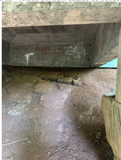
Figura 22 - Talude em bom estado de conservação
