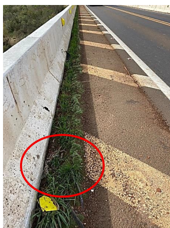
Tubulação obstruída
