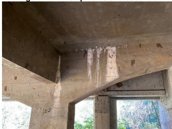
Figura 13 - Exemplos de eflorescência
