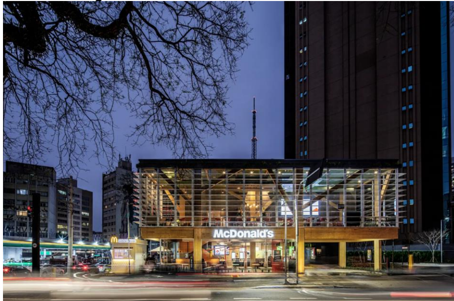
Figura 1 - Mcdonald's localizado em São Paulo
