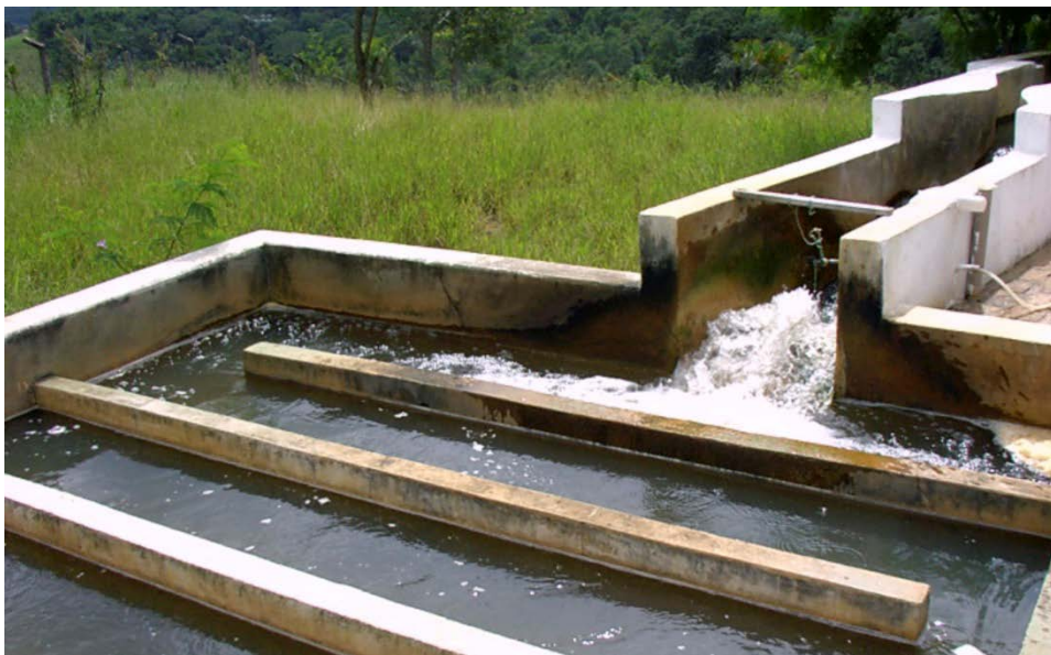
Figura 3 - Unidade de floculação logo após a saída da água da mistura rápida.
