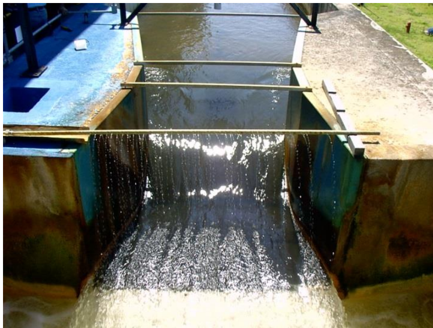
Figura 2 - Coagulação utilizando uma calha parshall para a mistura rápida.
