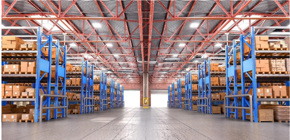
Figura 12 - Rack de armazenamento para estocagem dos produtos.
