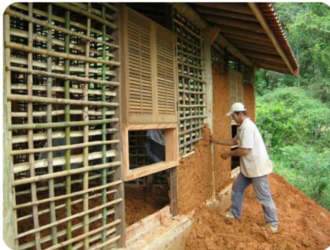
Figura 14 - Barro e bambu “pau-a-pique”
