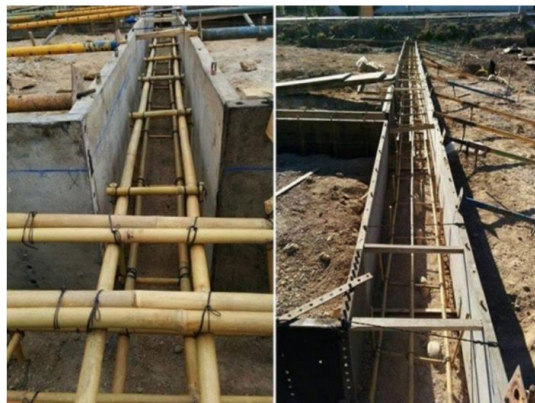
Figura 15 - Concreto armado de bambu
