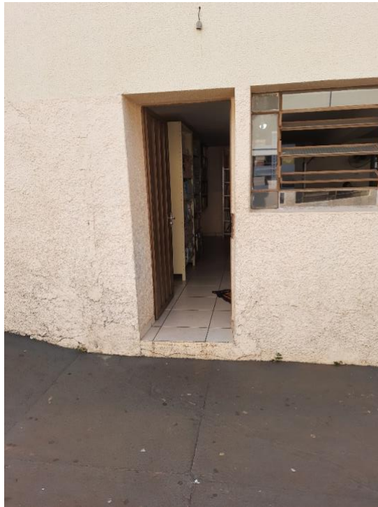
Fotografia 5 – Entrada da biblioteca
