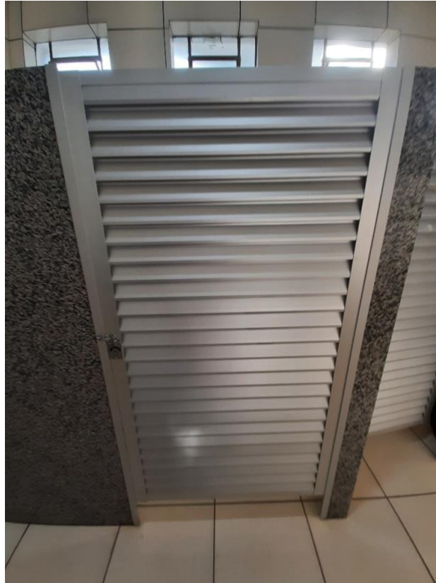
Fotografia 13 – Porta do banheiro
