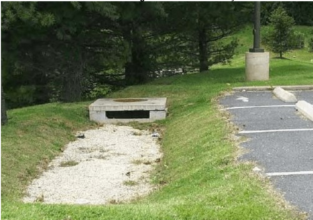
Figura 8 – Vala de Infiltração
